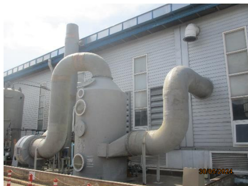
ภาพที่ 2-2 ระบบรวบรวมและระบบบำบัดมลพิษทางอากาศแบบเปียก (Wet Scrubber)
