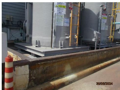
ภาพที่ 2-23 คันคอนกรีตล้อมถังรอบถังสารเคมี
