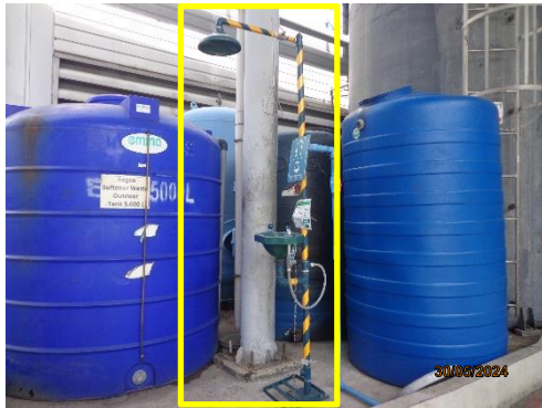
ภาพที่ 2-54 ฝักบัวและอ่างล้างตาฉุกเฉิน
