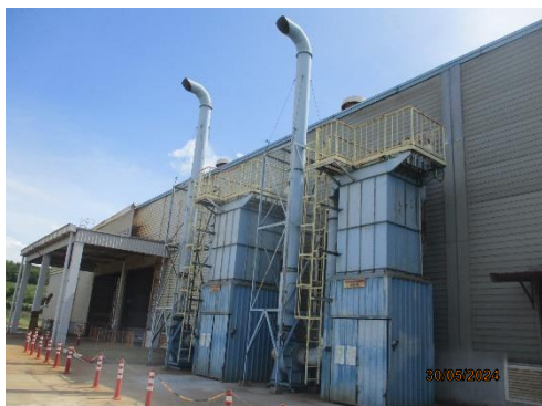
ภาพที่ 2-1 ระบบรวบรวมและดักฝุ่นแบบถูกรอง
